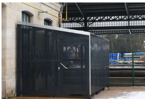
Stationnements vélo sécurisés à la gare de Bar-le-Duc
